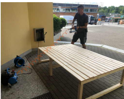
Bau einer Holzverkleidung für das Waschbecken
